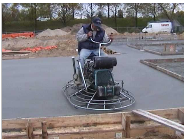
Figuur 2.7 Nabehandeling van vers gestort beton: belangrijk!
