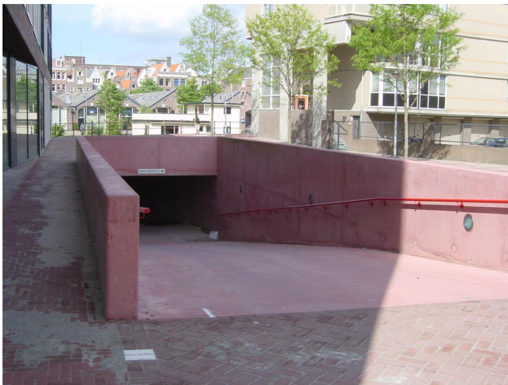
Figuur 2.15 Gekleurd beton.
