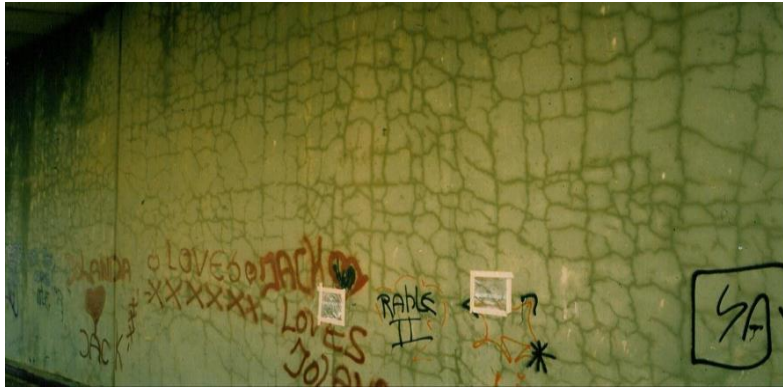
Figuur 2.13 ASR-aantasting
