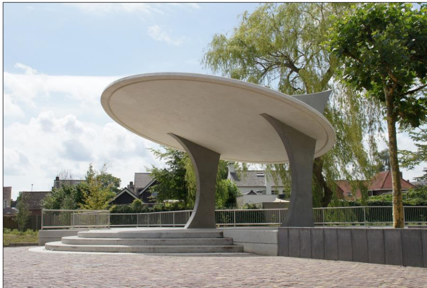
Figuur 2.5 Toepassing zelf verdichtend beton in Veldhoven (Fotografie Frank Beek)
