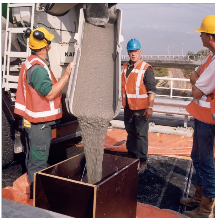
Figuur 2.4 Beton storten direct uit truckmixer
